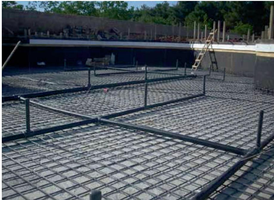
Havuz alt filtrasyon borulamasının yapılması
