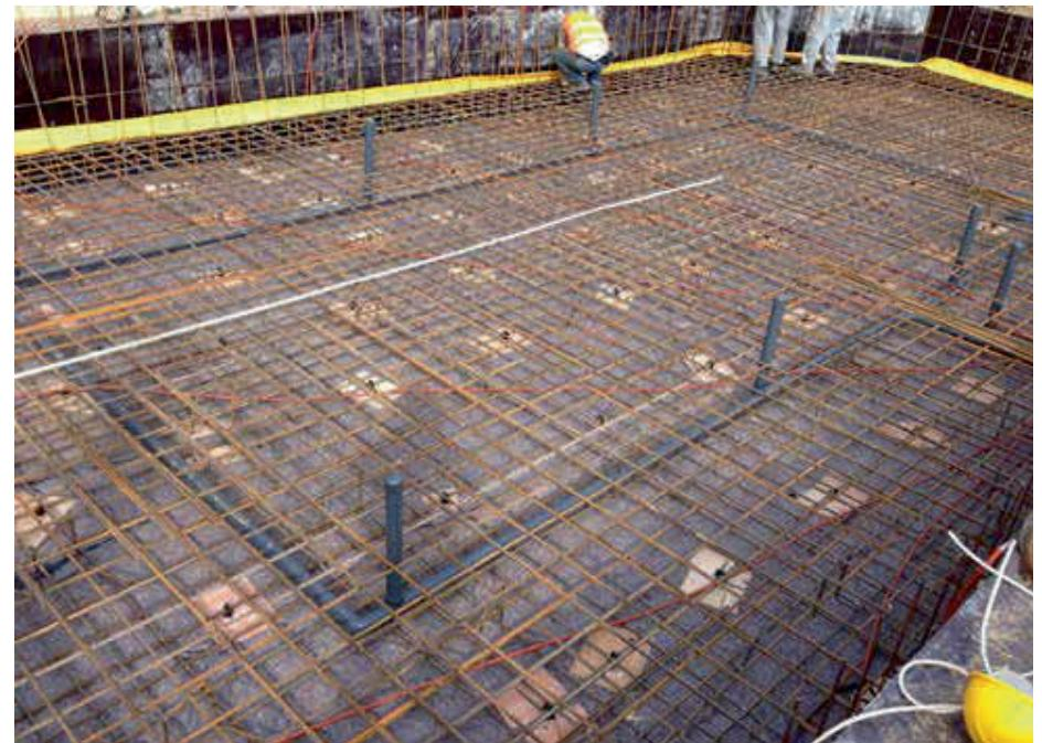
Radye alt demirinin döşenmesi, filtrasyon için alt borulamaya hazır hale getirilmesi
