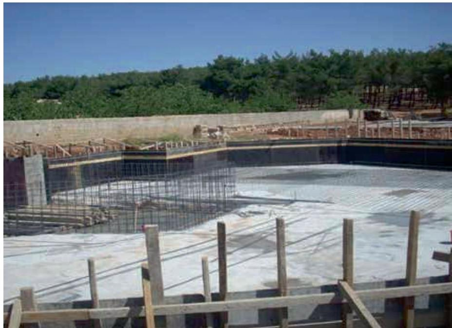
Havuz dış kalıbinin yapılması ve radye alt demirinin döşenmesi
